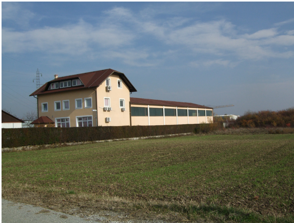
Slika 2: Poslovna građevina, [REDACTED], Sesvete – zapadno i južno pročelje
